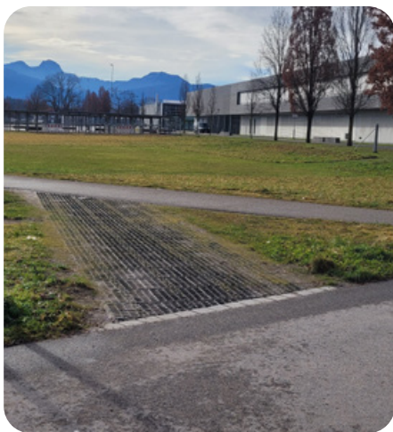
Der gern genutzte Trampelpfad bei der Pauline-Thoma-Schule ist jetzt angenehmer zu befahren: Bauhofmitarbeiter haben Rasenwaben verlegt.
