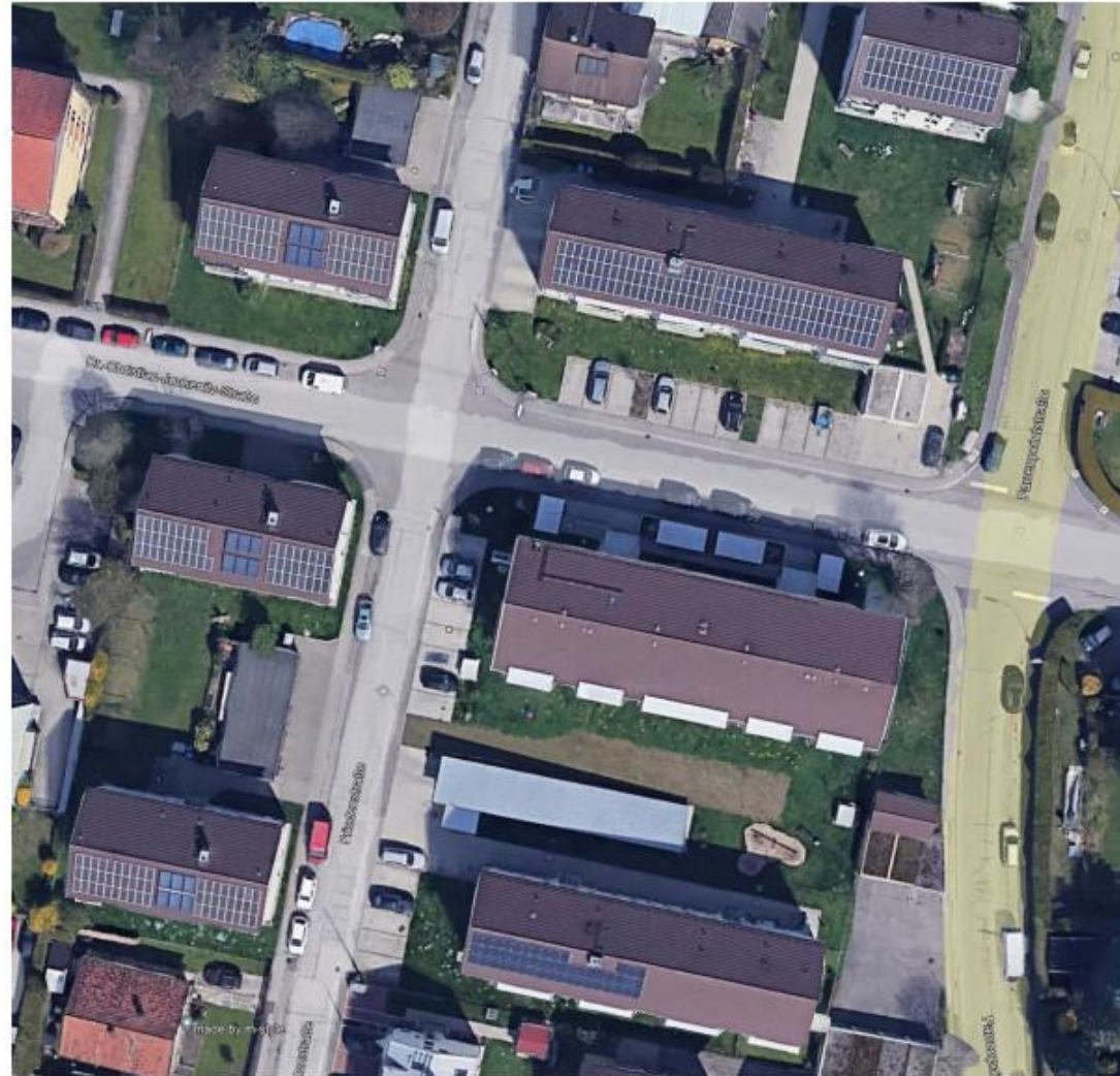
Abbildung 4: Ost/West Dächer Quelle: Google (o.D.)
