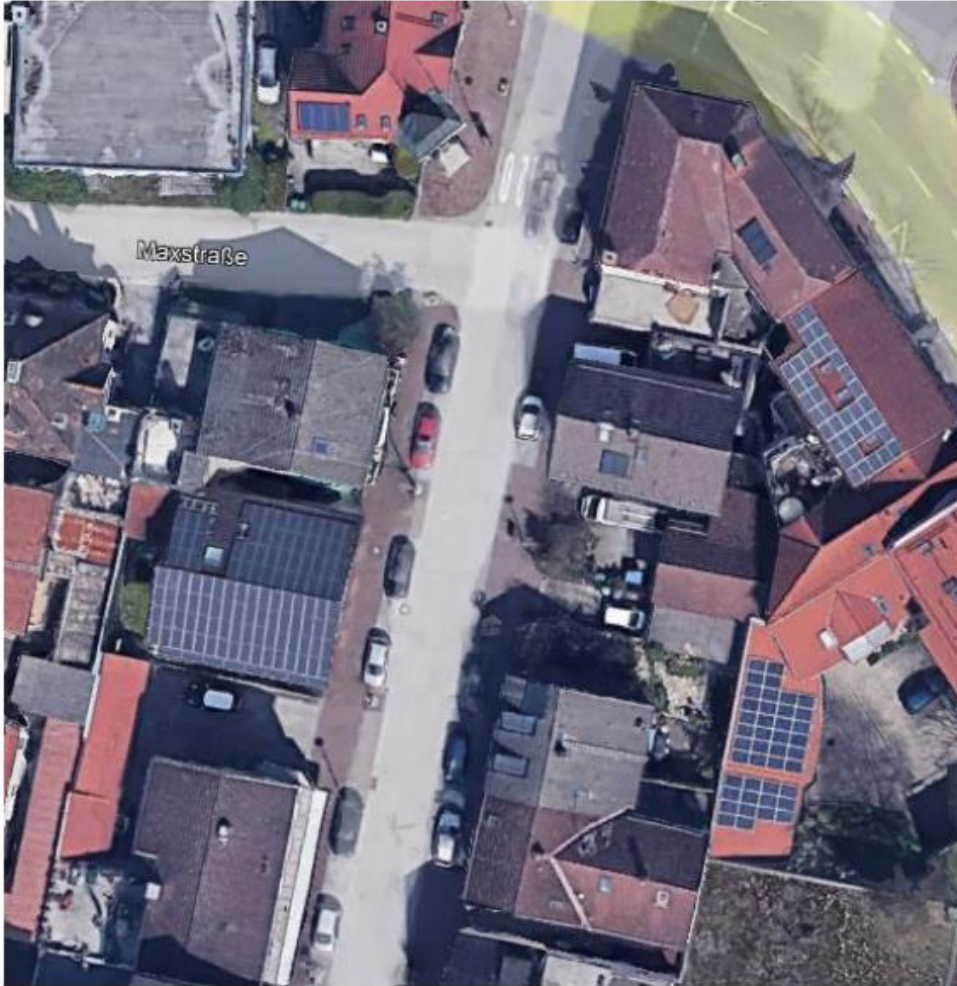
Abbildung 5: Ost/West Dächer Quelle: Google (o.D.)
