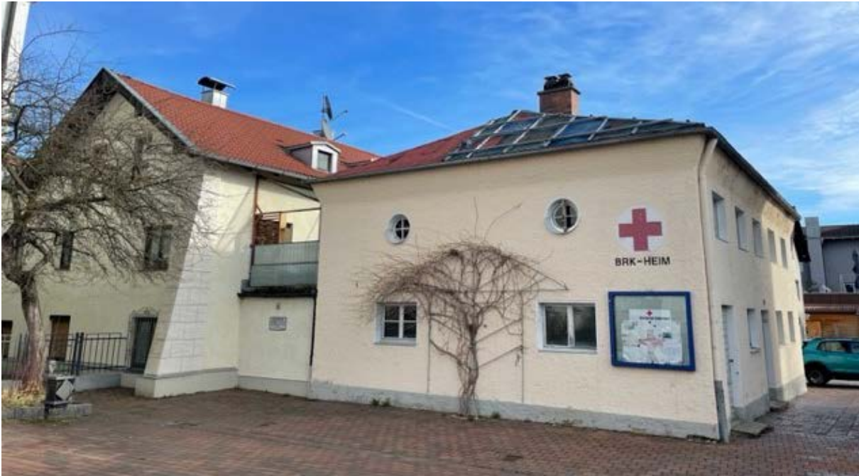
Abb. 8: BRK-Heim, Westansicht, Quelle: Stadt Kolbermoor, 2024
